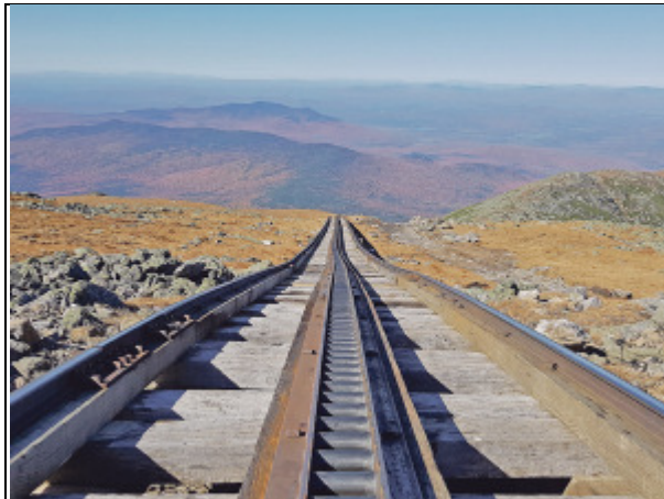
Sylvester Marsh liess Schienen und Zahnstange von der Talstation bis zum Gipfel auf Holzgerüsten festnageln. Bis heute ruht der Gleiskörper der Mount Washington Cog Railway auf sogenannten «trestle», einer für die USA typischen Konstruktionsweise für Brücken.
