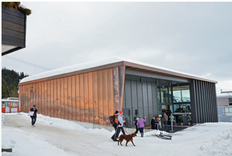
Aus Holz und Kupfer besteht die Aussenfassade der neuen Bahnstation.
