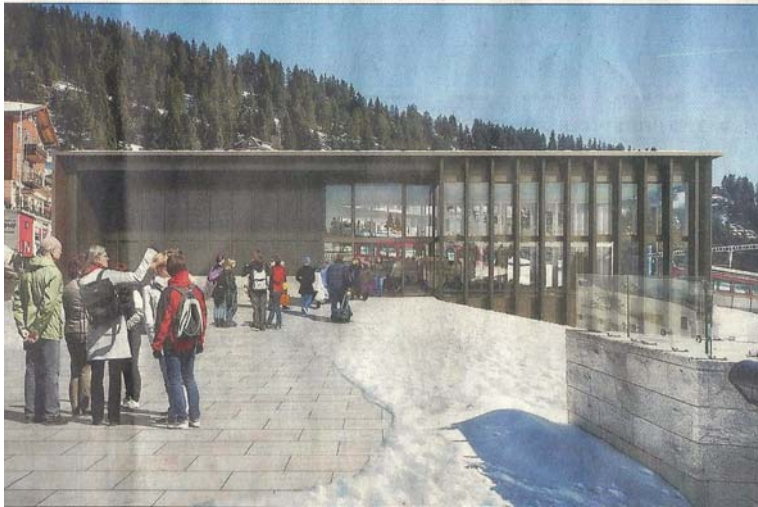
So soll das rund 3 Millionen Franken teure Stationsgebäude der Rigi-Bahnen auf Rigi Kaltbad dereinst aussehen.
