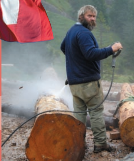
Hochdruck-Entrinden am Bauplatz
