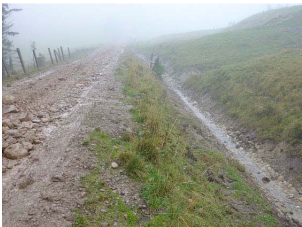
Der Panoramaweg mit den Rigolen, die das Wasser bergseits abführen.
